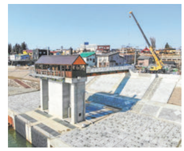
写真は令和6年3月に完成した小千谷頭首工
