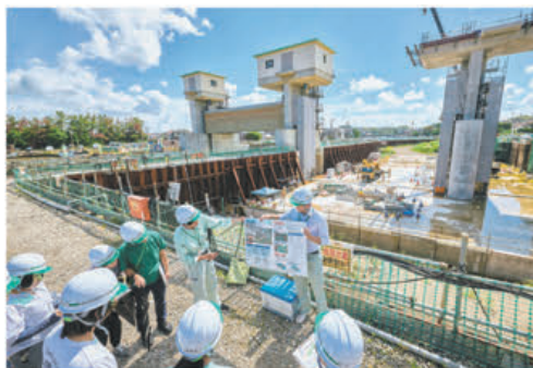
右岸の樋門は更新工事が令和5年に完了。同じものを左岸にも建設中
