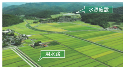
国と新潟県による工事が完了した水田地帯
